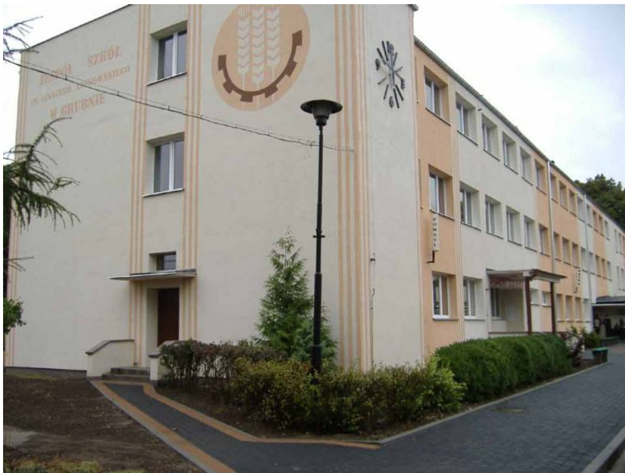
Budynek Zespołu Szkół Centrum Kształcenia Praktycznego w Grubnie
