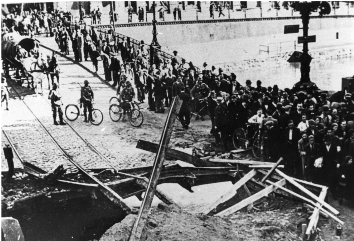
Zniszczony most w Bydgoszczy, wrzesień 1939 roku (z zasobów Archiwum IPN)
