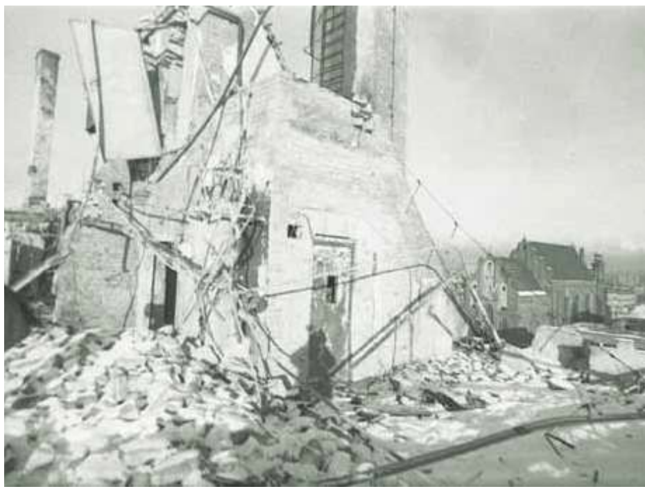
Górna kondygnacja zniszczonego budynku Komitetu Wojewódzkiego PZPR w Gdańsku. W tle kościół św. Józefa (AIPN Gd)
