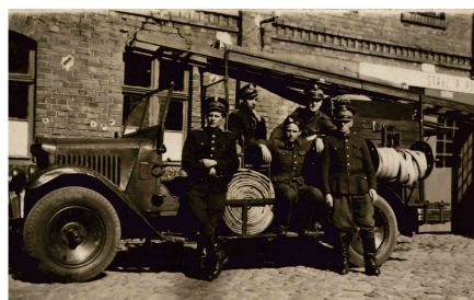
Zdjęcie wykonane w Elbląskiej Fabryce Urządzeń Kuziennych, przy Alei Grunwaldzkiej w latach pięćdziesiątych archiwum Eugeniusza Woźniakowskiego
