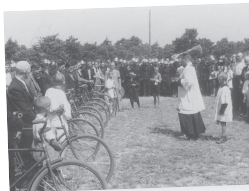
Poświęcenie rowerów dla wojska, ufundowanych przez robotników fabryki M. Cieurzyńskiego, lipiec 1939 r. zbiory Narodowego Archiwum Cyfrowego
