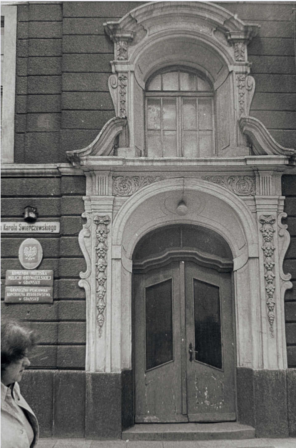
Wejście do budynku KM MO w Gdańsku, początek lat osiemdziesiątych XX w. (NID OTG)
